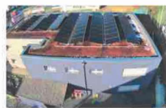
Unter anderem auf dem Schulhaus (oben) und der Kita wurden Solaranlagen installiert. zvg
